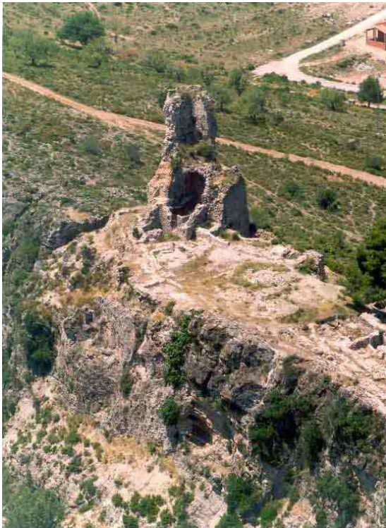
Fig. 6.- Vista del castillo antes de su intervención. (Fotografía de archivo de la UPV).
