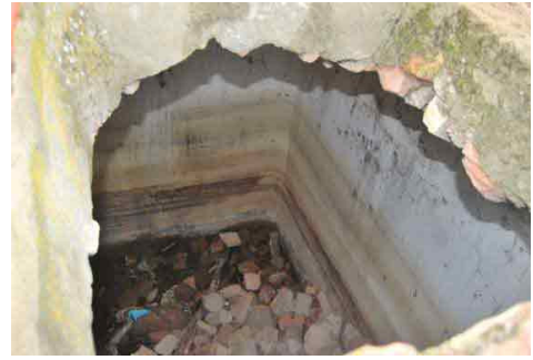
Fig. 5.- Intervención sobre el aljibe. (Fotografía de archivo de la UPV).
