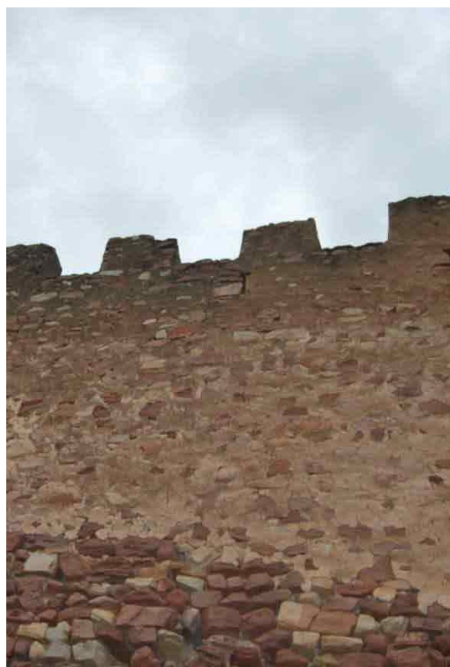
Fig. 3.- Muro del castillo realizado la parte inferior con mampostería y la superior con tapial. (Fotografía de archivo de la UPV).
